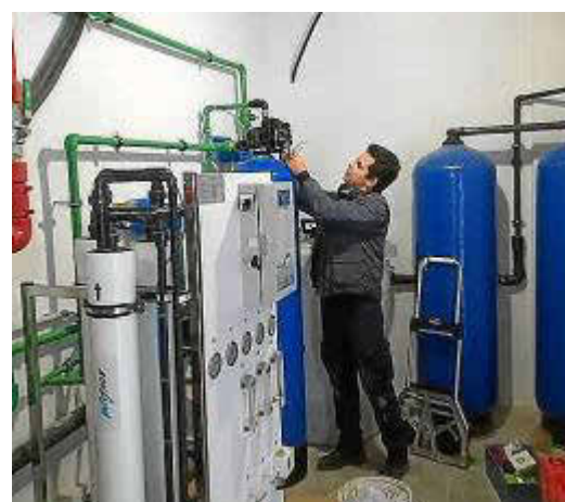
Planta de osmosis inversa instalada en un establecimiento hotelero de la Isla. Fotos: MARCOS ARROYO
